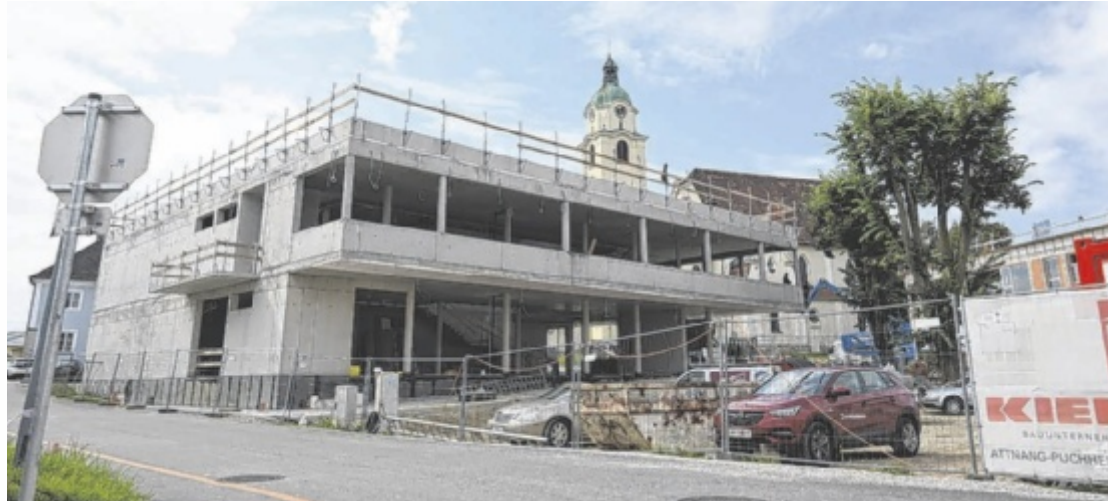
Großbaustelle im Ortszentrum: Derzeit wird an zwei neuen Gebäuden gearbeitet.
